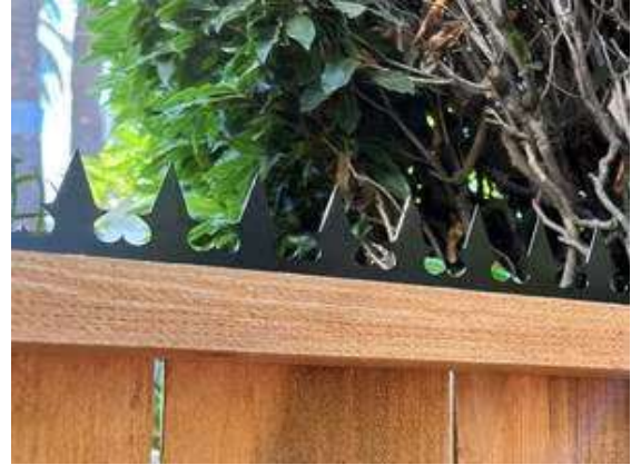
住宅の塀などに設置される忍び返し（ダイヤテック提供）
