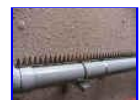
パイプ専用金具 (1セット2000円) を使用してパイプに取付。横引配管の忍び返し (鳩よけ) になります。
